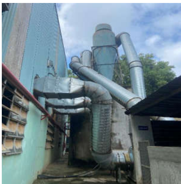
Hệ thống xử lý, thu hồi bụi gỗ
