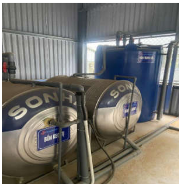
Hình 4.5. Hệ thống xử lý nước thải 15m 3 /ngày.đêm
