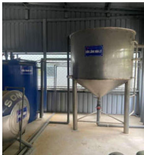
Hình 4.5. Hệ thống xử lý nước thải 15m 3 /ngày.đêm
